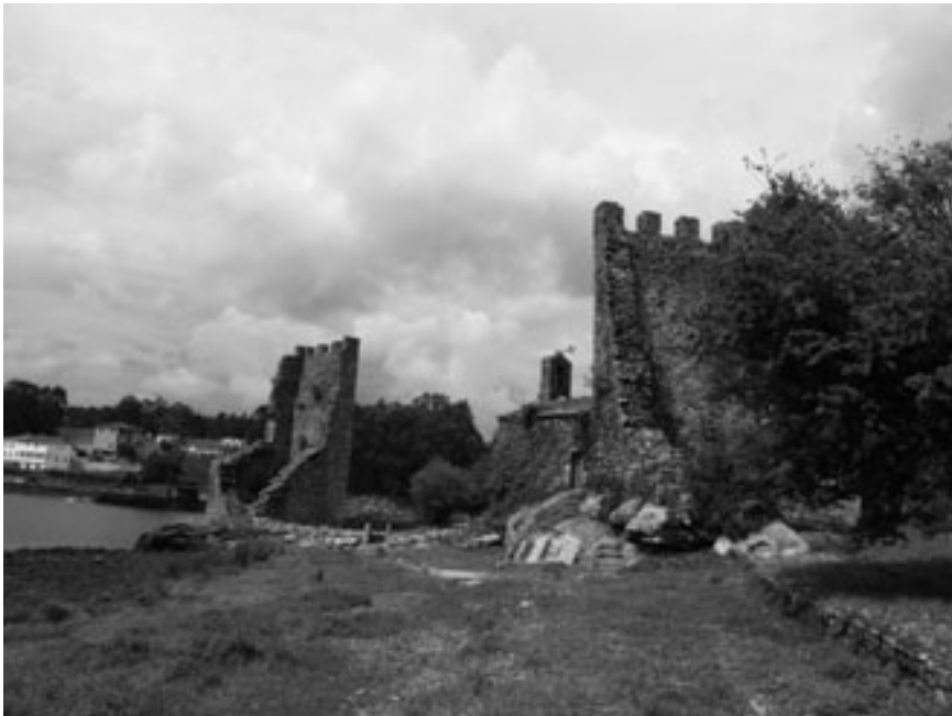
Figure 5.3 The Torres del Oeste.
